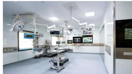
▲ Nuevo Quirófano de alta complejidad de Clínica Rotger.
